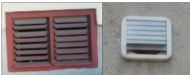
Obr. 10 a 11: Mřížky přes větráky na budově.
