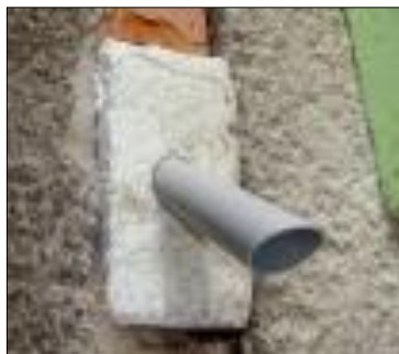
Obr. 13: Jednosměrná uzávěra z trubky
