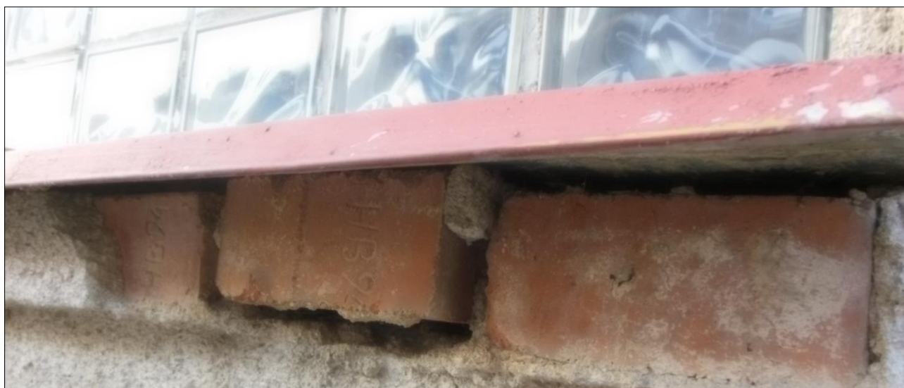
Obr. 2: Štěrbiny pod parapetem.
