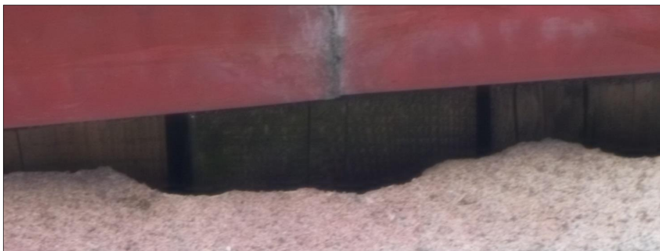
Obr. 3: Štěrbiny pod střechou přízemní budovy – přístavby.
