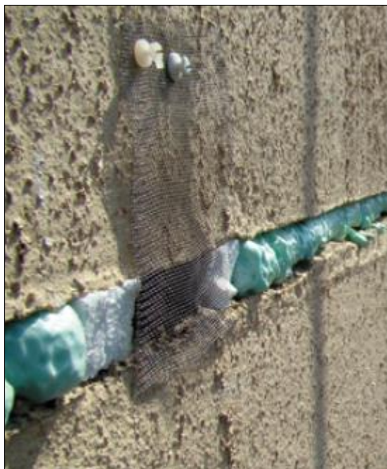
Obr. 14 a 15: Jednosměrná uzávěra. Sítka musí těsně přiléhat ke stěně domu a přesahovat otvor ze všech stran min. o 5 cm.
